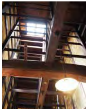
むき出しの梁など、建物の魅力を最大限に生かした改修
