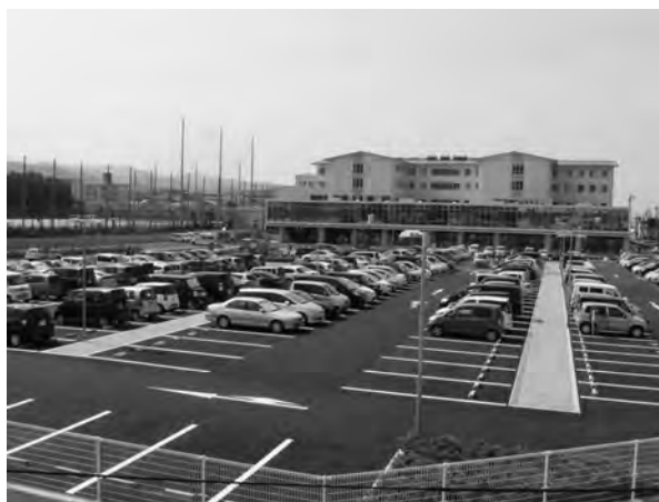
▲リニューアルされた駐車場
