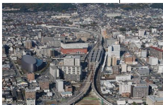
施工中のJR奈良駅付近連続立体交差事業
