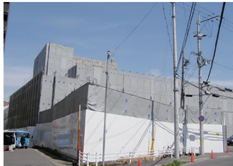
解体工事中の旧イオン富雄店(富雄元町二丁目)
