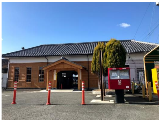
待合室部分外部工事完了写真(第一期工事) H30.3.31撮影
