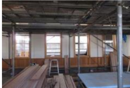
待合室部分内部工事写真(第一期工事) H29.12.15撮影
