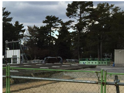
●中金堂北西回廊基壇復元工事(南から)(平成29年度 (12月撮影)
