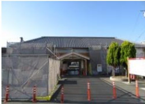
待合室部分外部工事写真(第一期工事) H29.12.15撮影
