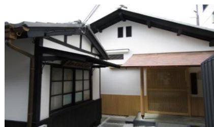
【修理後】H29.6.28撮影
