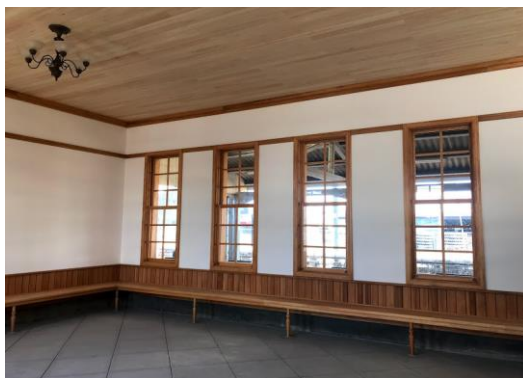
待合室部分内部工事完了写真(第一期工事) H30.3.31撮影
