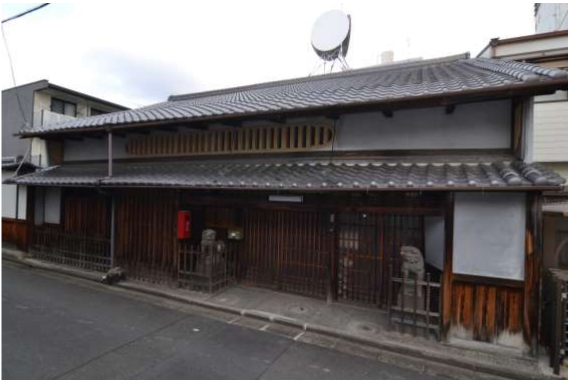
永井家住宅主屋 正面外観
