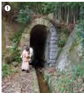
①現在も水路として利用される鹿川隧道
