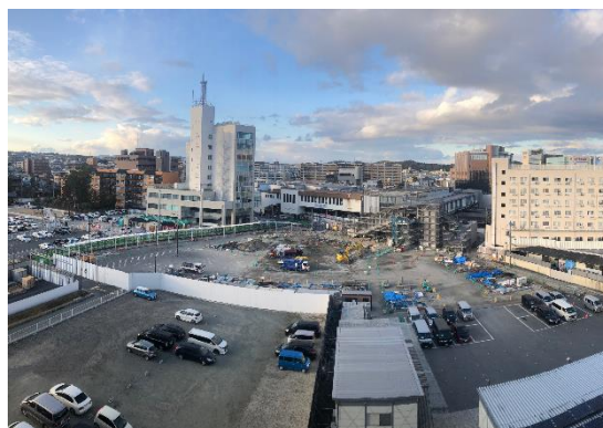
駅南側（現況写真）
