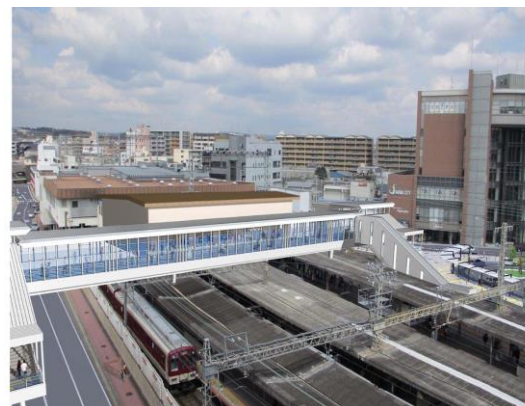
南北自由通路（外観）
