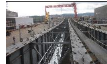
橋梁上部工 工場検査（橋桁仮組立）
