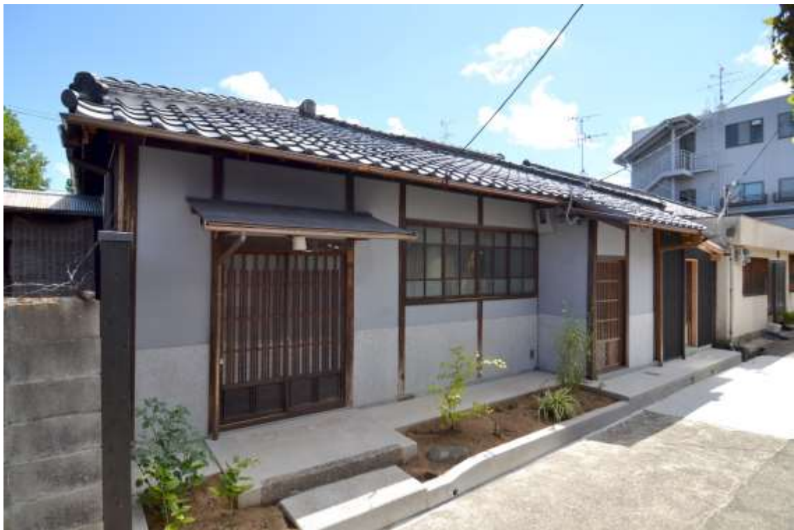
内山家貸家 正面外観
