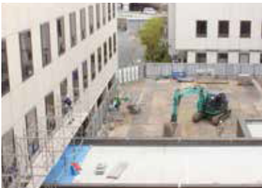
4階連絡通路から望む中庭の足場設置工事の様子（昨年12月3日撮影）。工事の進捗状況は、随時しみんだより等でお知らせします。
