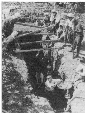
鳴川町の防空壕づくり
