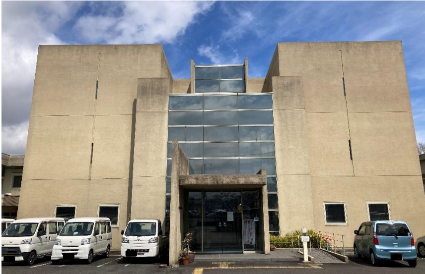
図 1.1 埋蔵文化財調査センター外観
