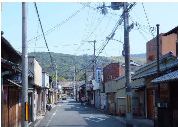
張り巡らされた電線類（一条通）
