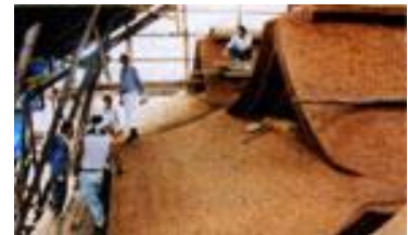
平成7年度の本社本殿檜皮屋根の葺き替え(春日大社HPより)
